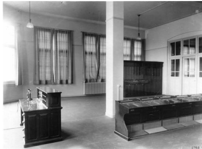
Foto: Supervisor post en telefonisten-tafels in de halfautomatische Rotary centrale van Scheveningen.
